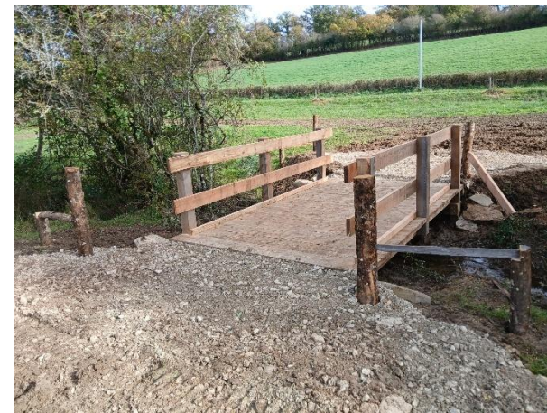
Exemple de passerelle bois proposée (travaux BV Ouyse-Alzou en 2025)
