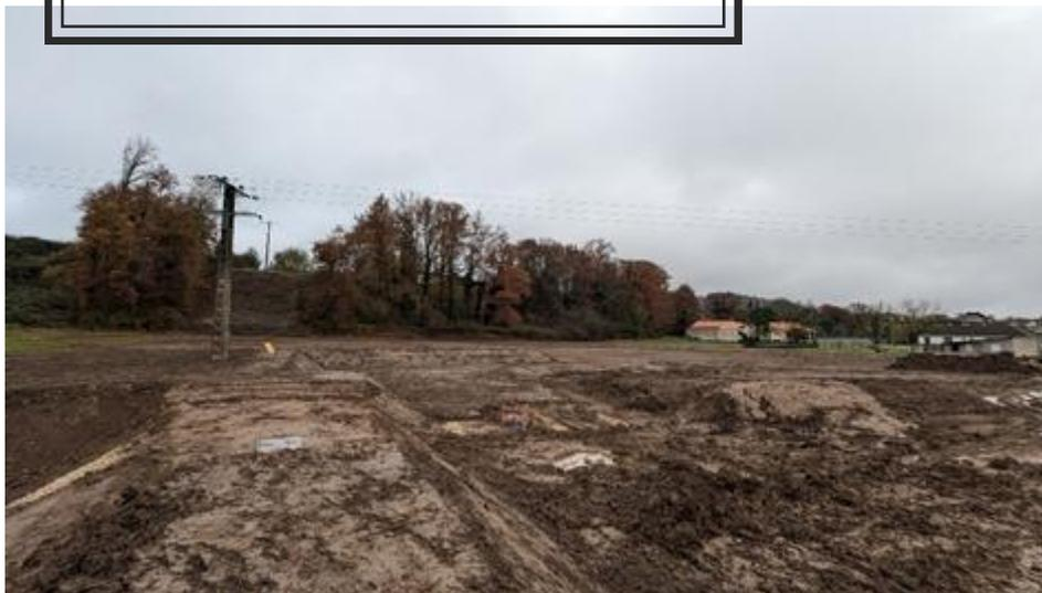
Les travaux ont démarré en septembre 2024 et se termineront au printemps 2025 en raison d'une pluviométrie trop importante et un engorgement des sols. Un suivi des eaux infiltré sera mené en partenariat avec le SYDED lors des épisodes de remplissage du bassin.
